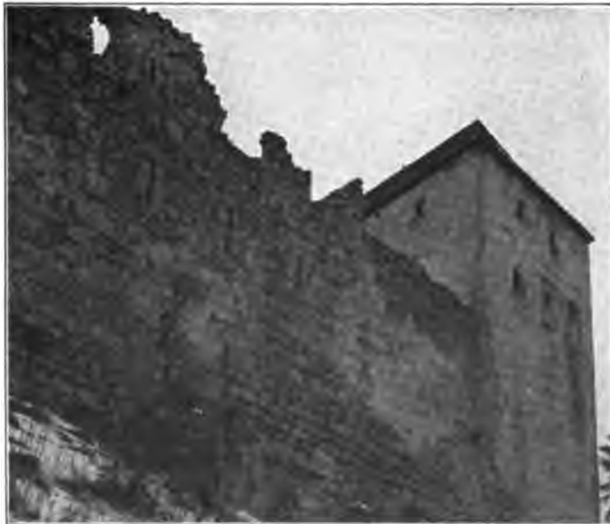
Fig. 144. Stockenfels. Ansicht der Burgruine, Ostseite.
